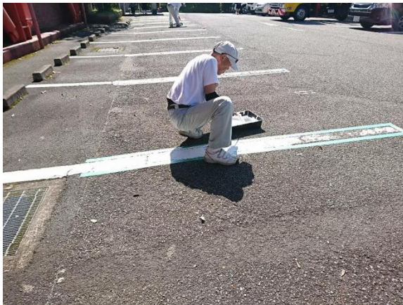
▲駐車場の白ライン表示修繕
